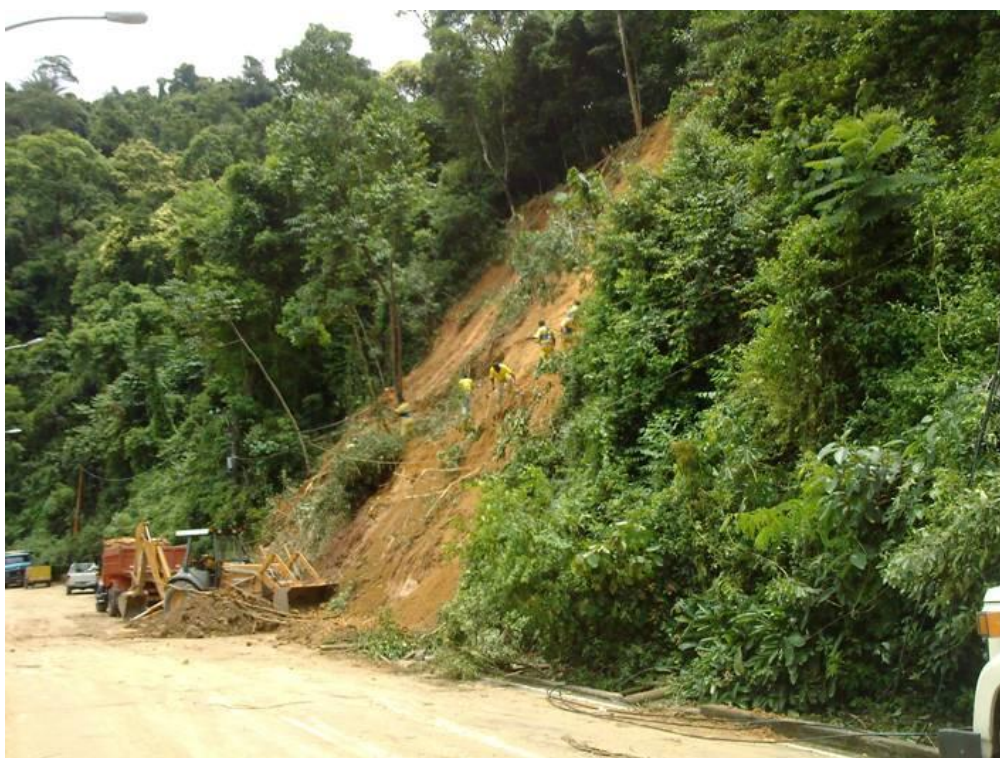
Estrada Grajaú – Jacarepaguá – 30/12/2009 – Escorregamento planar de solo residual em talude de corte lateral à via.
