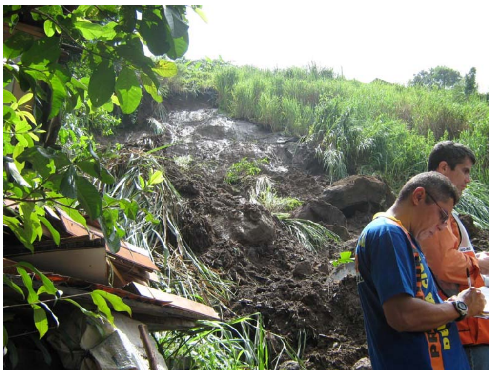
Morro dos Macacos – 01/04/2009 – Escorregamento planar de solo coluvionar em talude de corte a montante de moradia
