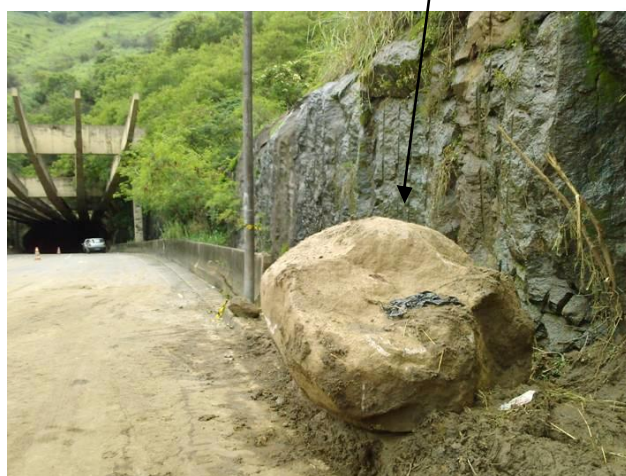
Emboque Norte do Túnel Noel Rosa - 30/12/2009 – Escorregamento de solo coluvionar e blocos de rocha de talude adjacente ao emboque do túnel.
