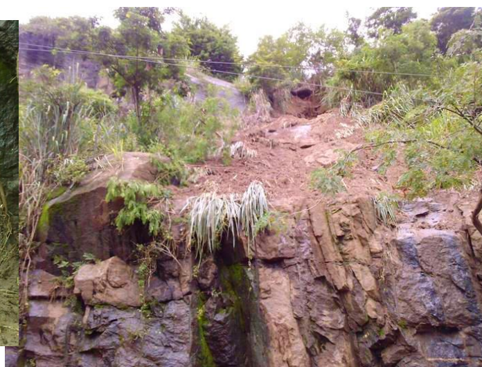
Emboque Norte do Túnel Noel Rosa - 30/12/2009 – Escorregamento de solo coluvionar e blocos de rocha de talude adjacente ao emboque do túnel.
