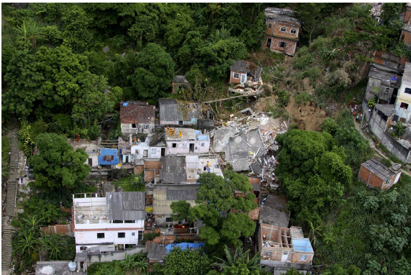
Praça Seca – Jacarepaguá – 30/12/2009 - Escorregamento de solo coluvionar e blocos de rocha causando destruição de moradias e três
