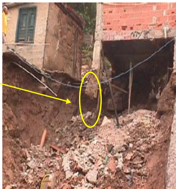
Escorregamento planar de solo residual/aterro, descalçando as fundações da moradia de montante e soterrando a de jusante (direita).
