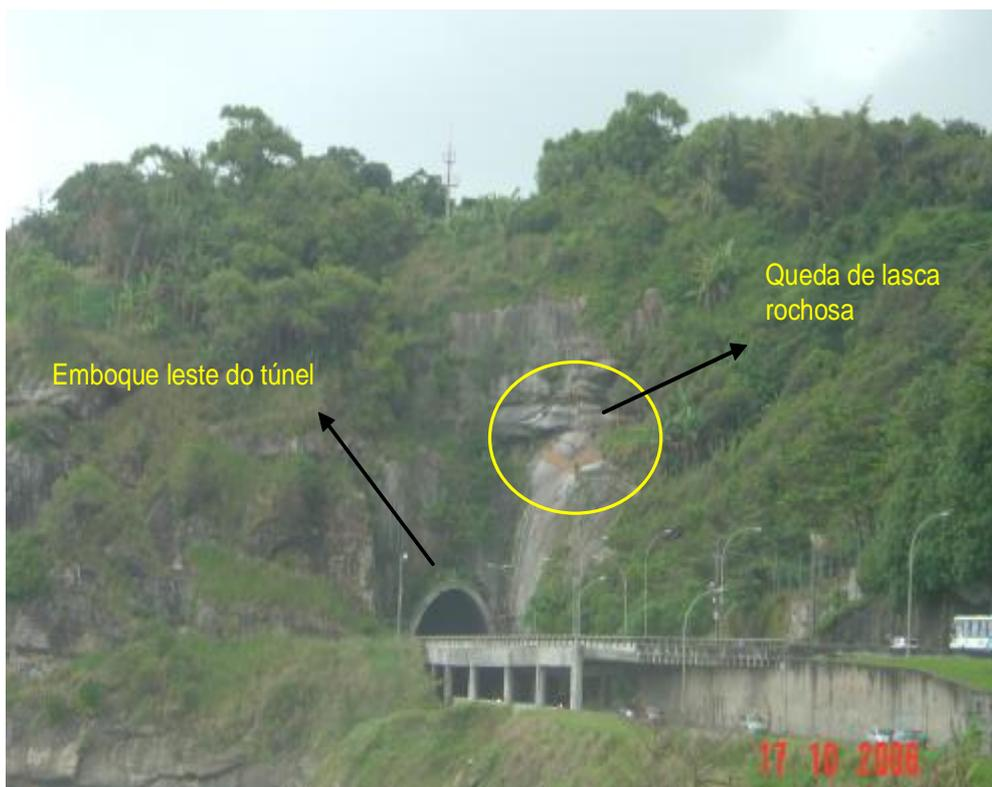
Queda de lasca rochosa ( 3m3 ) atingindo a pista de rolamento no emboque do túnel à montante
